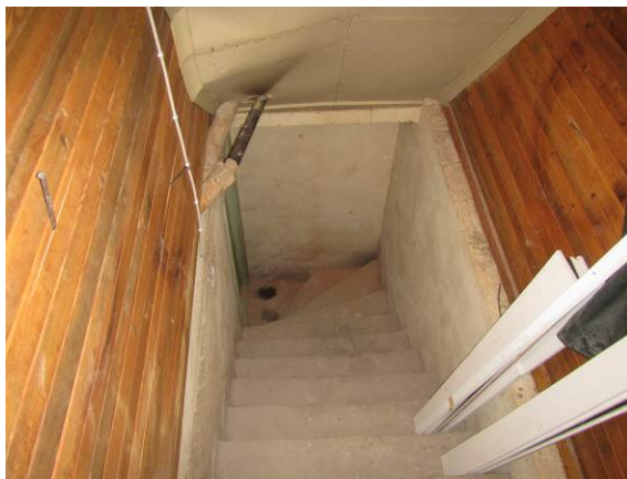
Kuva 9. Sisäänkäynti kellarikerrokseen. Voimakas mikro- beihin viittaava haju.
