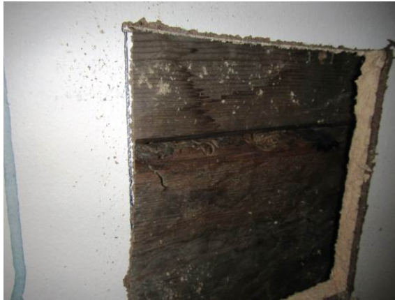
Kuva 25. RA4. Hirsirungon sisäpinnassa kosteusjälkiä.
