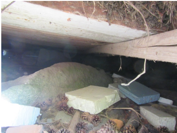
Kuva 17. Pääsisäänkäynnin kohdalla eristeen kannatinlaudoitusta puuttuu. Sammaleristettä näkyvillä.
