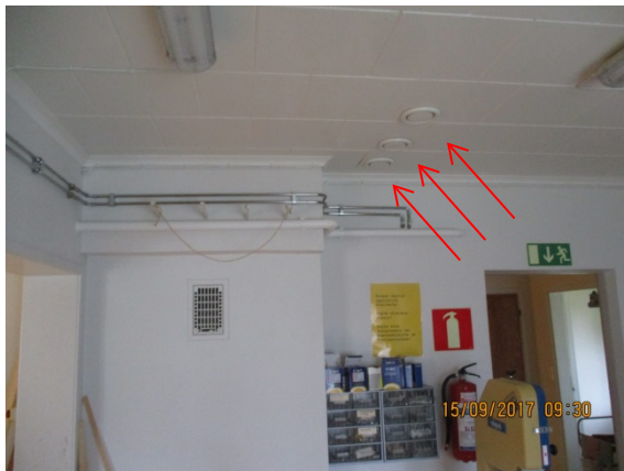
Kuva 40. Yleiskuva teknisen käsityötilasta. Poistoilma on toteutettu Halton UHA poistoilmaventtiileillä.
