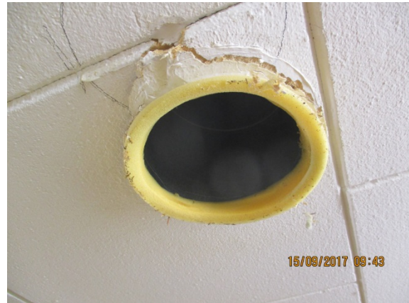
Kuva 43. Yläpohjan läpi menevissä kanavissa havaittiin viitteitä myös puutteellisesta kannakoinnista. Kanava on pudonnut alaspäin alkuperäisestä asennuskohdasta ja kattopinta on revennyt kanava mukana.
