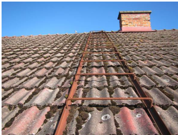
Kuva 30. Kattotiilien pinnalla sammalkasvustoa.
