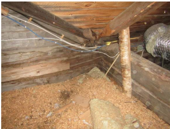
Kuva 34. Hirsirungon nurkkakohdalla kosteusjälkiä.
