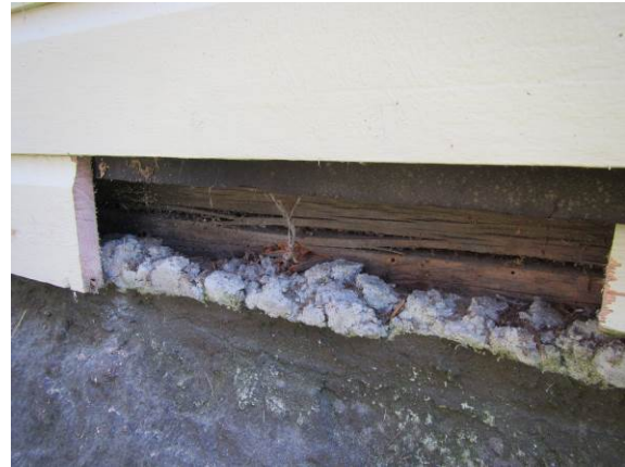
Kuva 26. RA6. Hirsissä kovakuoriaisten käytäviä ja lahovaurioita.
