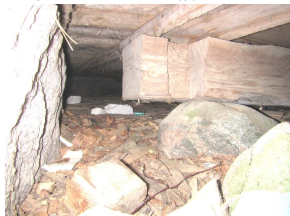
Kuva 16. Alapohjan kannatin laudoissa lahovaurioita. Maapohjan päällä orgaanista materiaalia.
