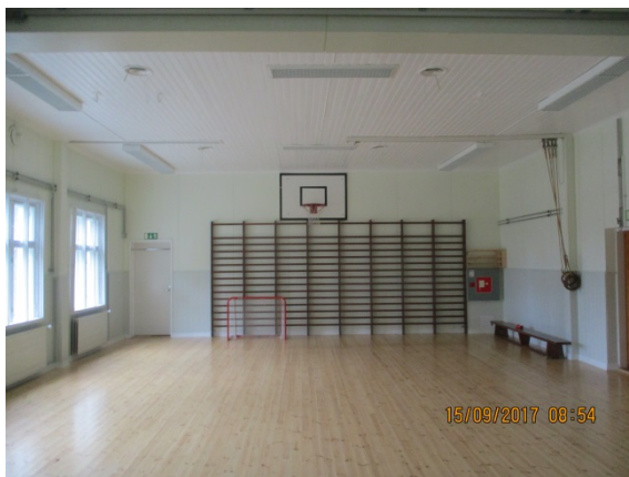
Kuva 36. Yleiskuva urheilusalista. Tuloilma jakautuu tasaisesti koko salin alueelle kuudesta tuloilman päätelaitteesta.
