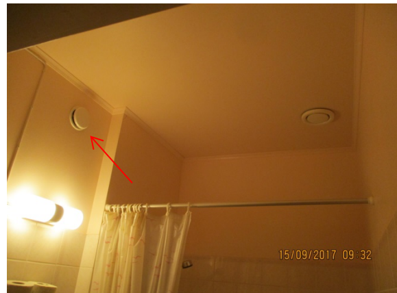
Kuva 41. Teknisen käsityötilan wc-/suihkutilan seinässä on vanhaan rakenneaineeseen hormiin liitetty lautasventtiili. Vanhat painovoimaisen ilmanvaihdon venttiilit tulisi poistaa ja tulpata.
