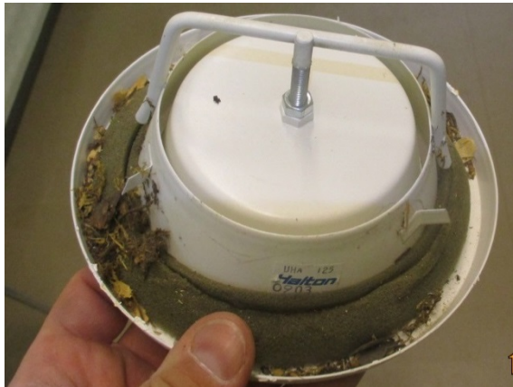
Kuva 42. Yläpohjan kanavaläpiviennit ovat epätiivittä ja yläpohjan sammaleristeet varisevat ja päätelaisiin.
