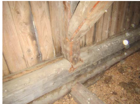
Kuva 35. Päätykolmion laudoituksessa kosteusjälkiä.
