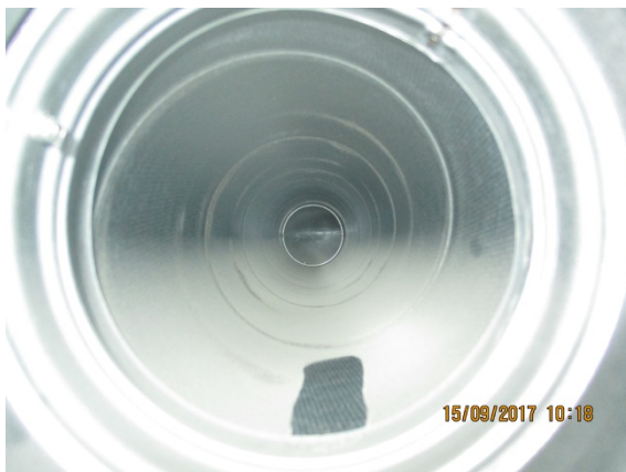
Kuva 46. Pukuhuoneen tuloilmapäätelaitteen liitäntäkanavassa on selvästi erottuva pölykerros.
