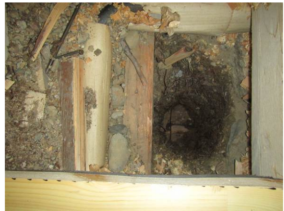
Kuva 20. RA1. Sammal tummunutta eristetilan pohjalla.
