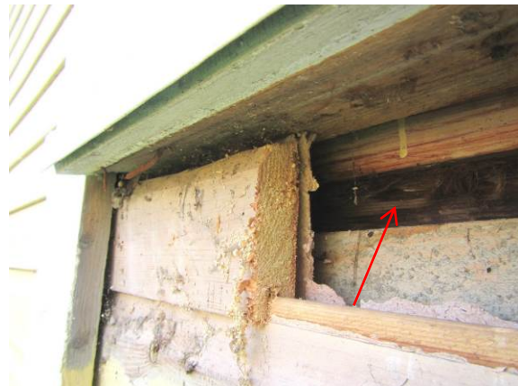
Kuva 28. Ikkunan tukirakenteissa kosteuden aiheuttamia tummentumia.
