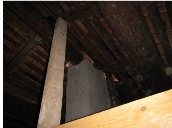
Kuva 33. Savupiipun läpivienti vaikutti epätiiviyttä.
