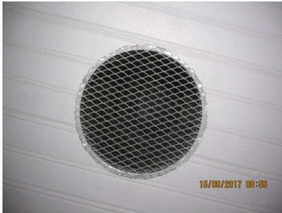
Kuva 38. Salin poistoilmapäätelaitteina on 2 kpl imukartioita suojaverkoilla. Ilmavirta säädetään liitäntäkanavassa olevista säätöpelleistä.
