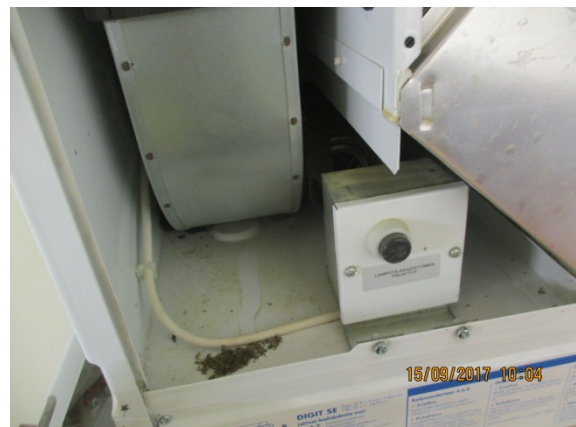
Kuva 47. Ilmanvaihtokoneessa havaittiin epäpuhtauksia.
