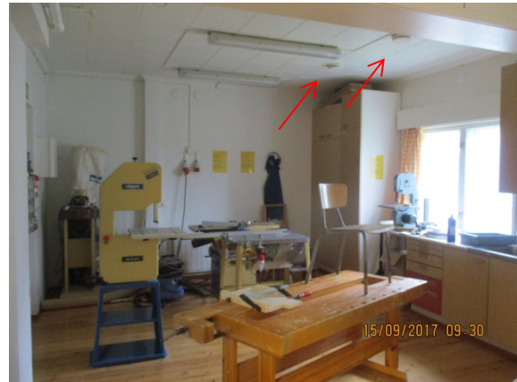
Kuva 39. Yleiskuva teknisen käsityötilasta. Tuloilma tuodaan tiloihin katosta Halton ULA tuloilmaventtiileillä.
