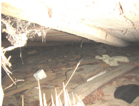
Kuva 15. Alapohjarakenne painunut.
