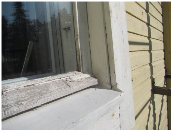
Kuva 27. Ikkunan vesipellin asennus ei ole tiivis.
