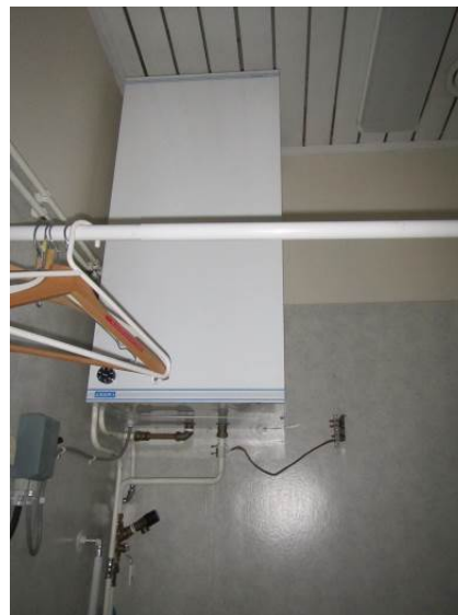
Kuva 4. Lämminvesivaraajan kohdalla mikrobeihin viittaavaa hajua.
