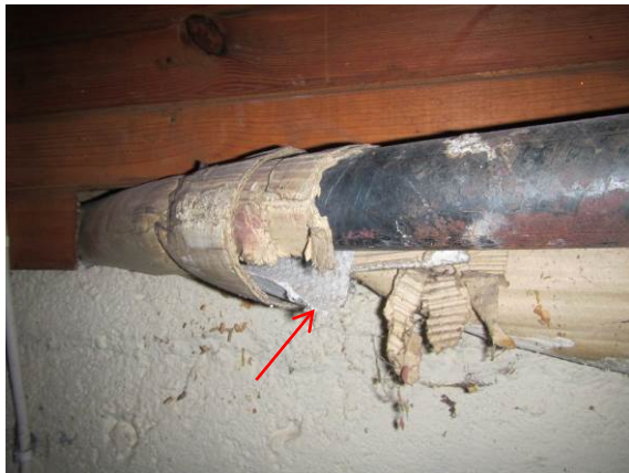
Kuva 1. Asbestia sisältävää putkieristettä paljaana.
