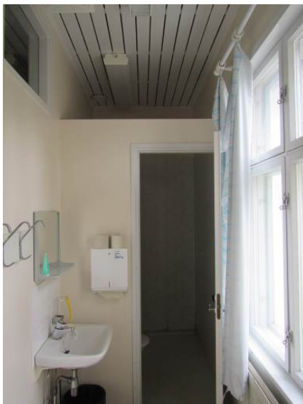
Kuva 3. Pistävä haju pukuhuone-/ KPH -tilan sisäilmassa.
