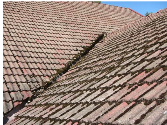
Kuva 31. Jiiritaitetta ei päästy tarkastamaan.
