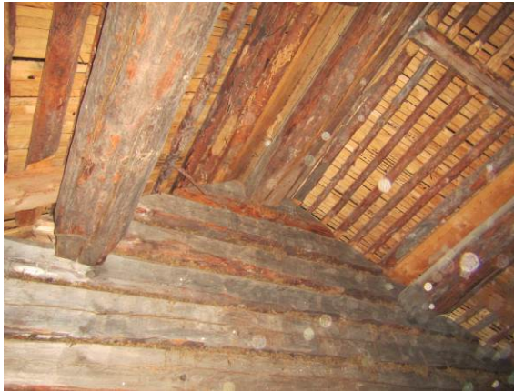
Kuva 32. Vesikattorakennetta teknisen työn tilan päädyssä.
