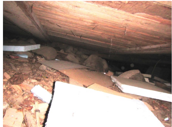
Kuva 18. Ryömintätila matalaa ja tukeutuu paikoin maapohjan päälle.
