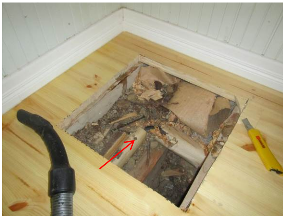
Kuva 19. RA1. Avauskohdalla asbestia sisältäviä putkieristeitä.
