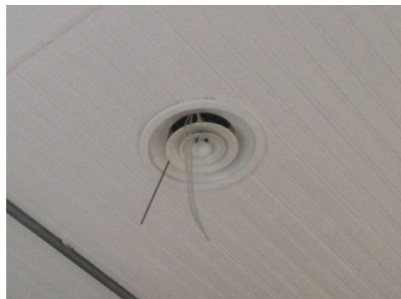
Kuva 37. Yleiskuva salin tuloilmapäätelaitteesta (KH, Fläkt). Päätelaitteiden mittausletkut ja säätövaijerit ovat jääneet roikkumaan päätelaitteen ulkopuolelle edellisen säädön jälkeen.
