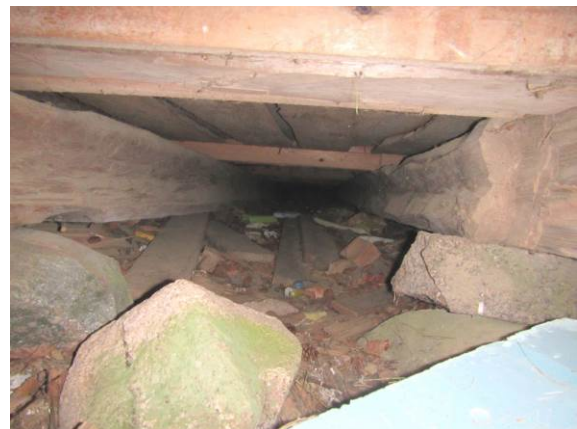
Kuva 14. Alapohjan kannatinpalkit tukeutuvat paikoin maahan. Ryömintätilan tuulettuminen estyy paikoin kokonaan.
