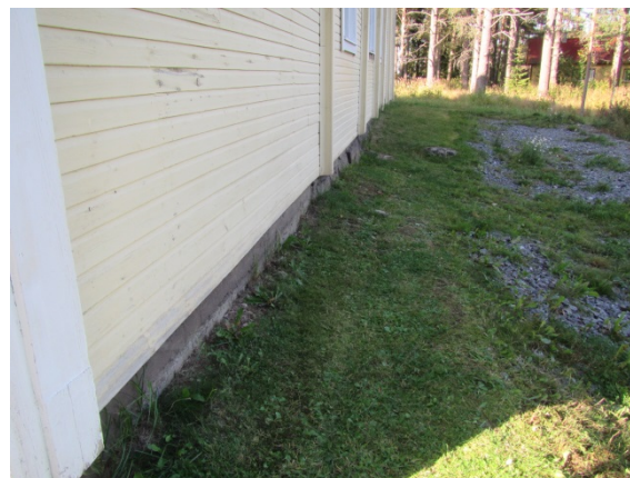
Kuva 8. Rakennuksen idän puoleista sivustaa.
