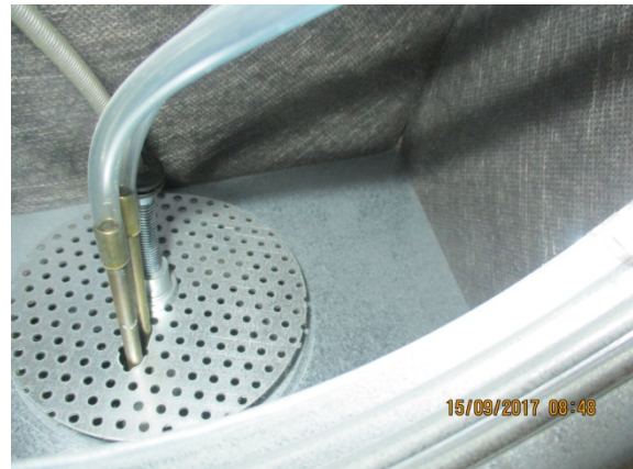
Kuva 45. Tuloilman päätelaitteiden paineentasauskammiot ovat suhteellisen puhtaat. Ääneneristysmateriaalina keino-kuitu.
