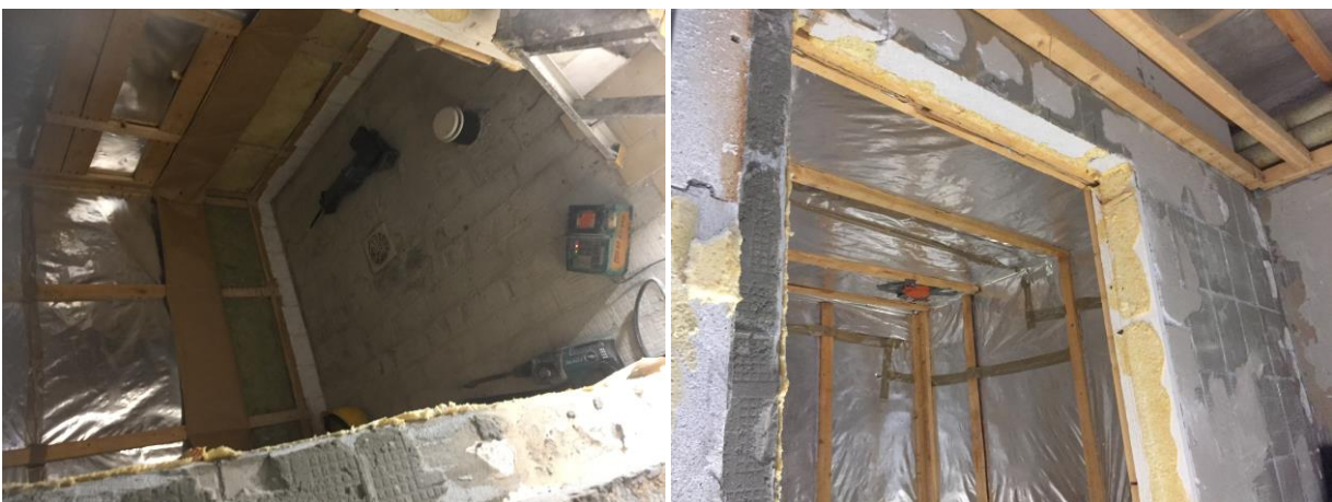
Purkutyöt on aloitettu. Saunan paneelit on purettu pois, samoin lattian laatoitukset.
